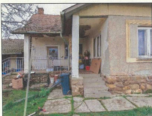
A lakóépület udvar felőli homlokzata.
