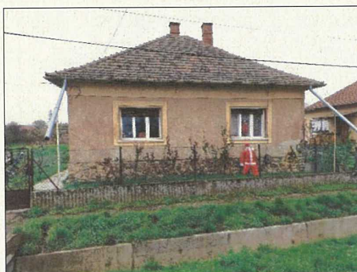
A lakóépület utcafronti homlokzata.
