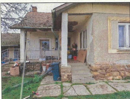
A lakóépület udvar felőli homlokzata.
