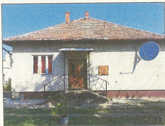
A lakóépület udvar felőli homlokzata.
