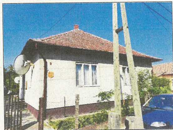
A lakóépület utcafronti homlokzata.
