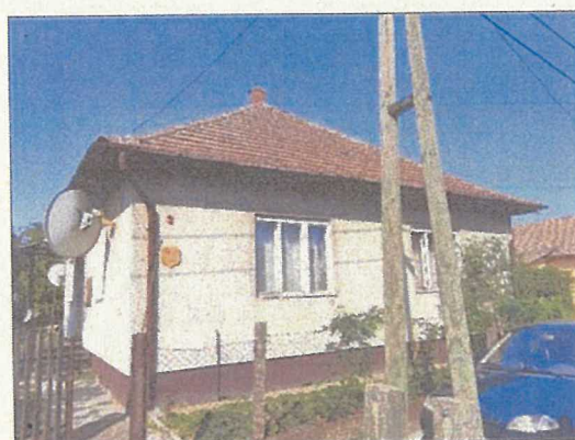
A lakóépület utcafronti homlokzata.
