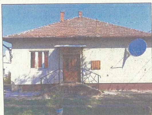
A lakóépület udvar felőli homlokzata.
