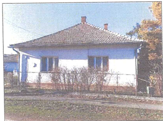
A lakóépület utcafronti homlokzata.
