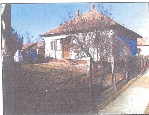
A lakóépület udvar felőli homlokzata.
