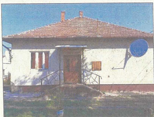
A lakóépület udvar felőli homlokzata.
