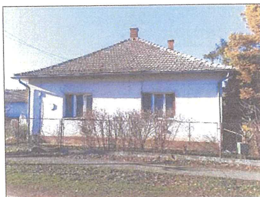
A lakóépület utcafronti homlokzata.
