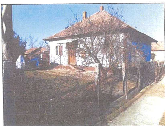
A lakóépület udvar felőli homlokzata.
