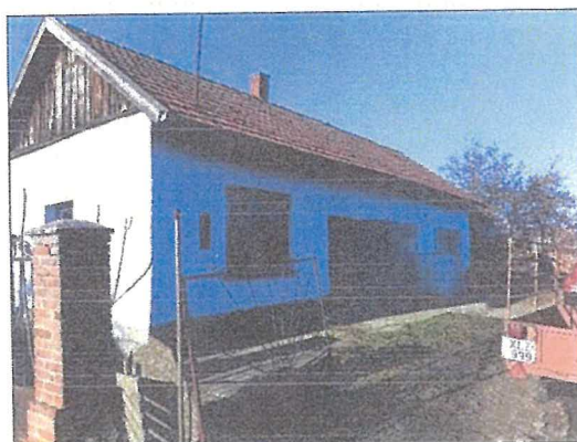
A gazdasági épület udvar felőli homlokzata.
