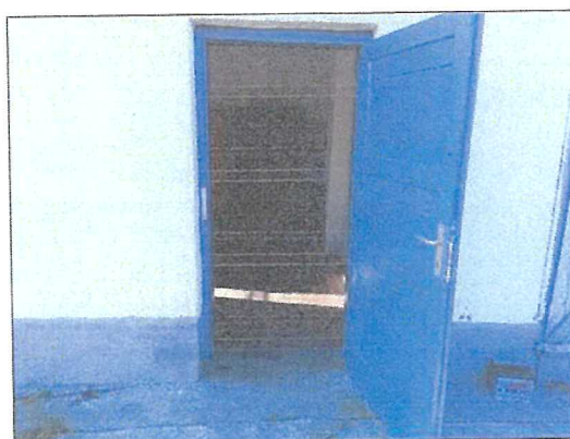
Az épület bejárata.
